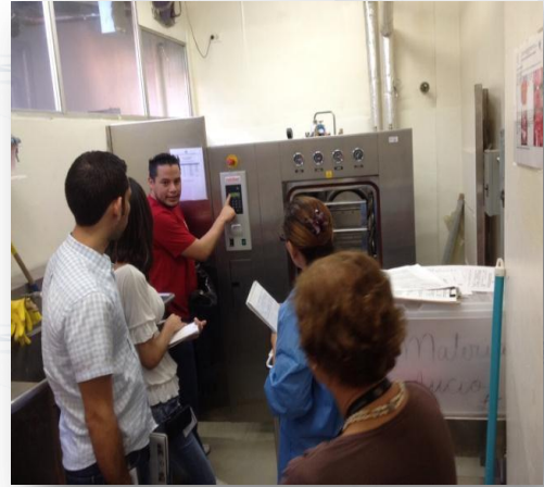
Instalación de la Autoclave
