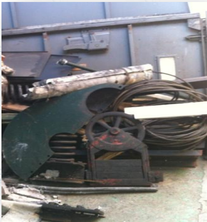
Remodelación del Montacargas – Desmonte del existente
