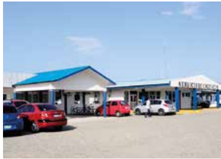
Hospital de Almirante
