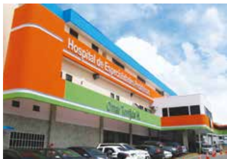
Hospital de Especialidades Pediátricas "Omar Torrijos Herrera."
