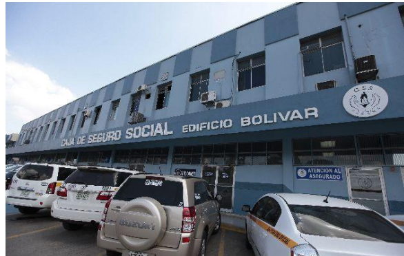
Edificio Bolívar (Transistmica)
