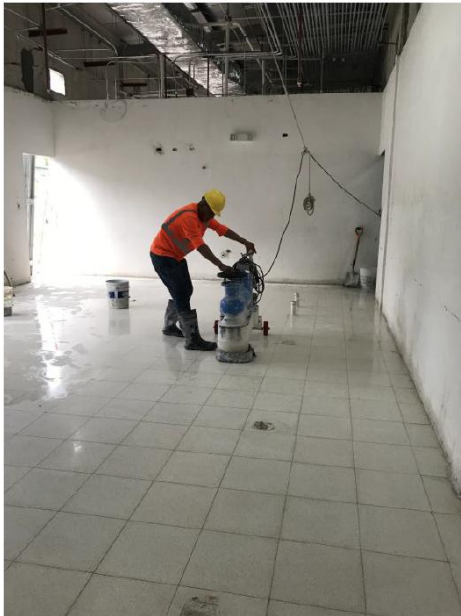
Pulimiento de pisos en cocina – Módulo G
