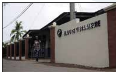
Vista Alegre, Arraiján, Panamá Unidad Local de Atención Primaria de Salud (ULAPS) Construcción de Cerca Entregado
