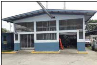
Hospital de Changuinola, Bocas del Toro Edificio de Calderas Entregado
