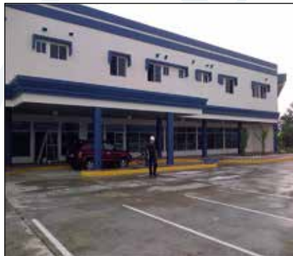
Hospital de Changuinola, Bocas del Toro Consulta Externa Entregado
