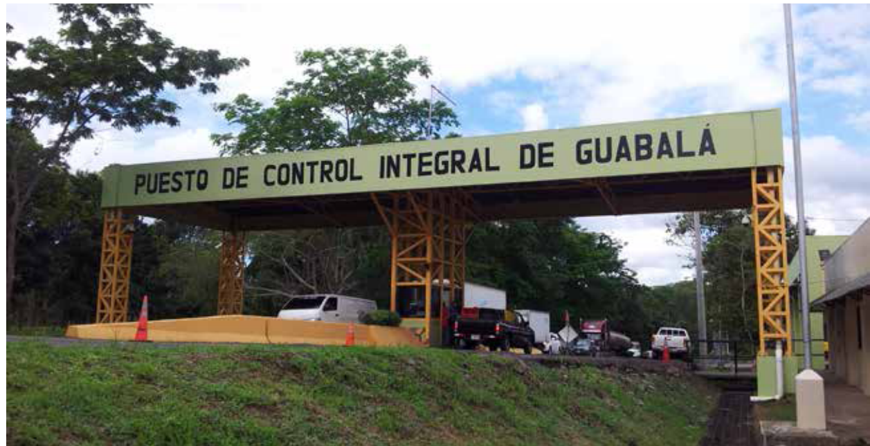
Rehabilitación del puesto de control integral de Guabalá de la Policía Nacional, provincia de Chiriquí. Monto B/.186,948.85.
