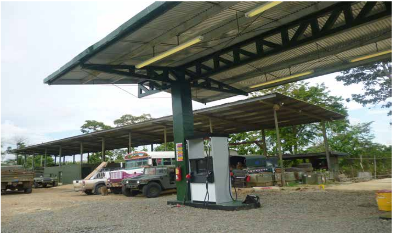
Estación de combustible de Metefí.
