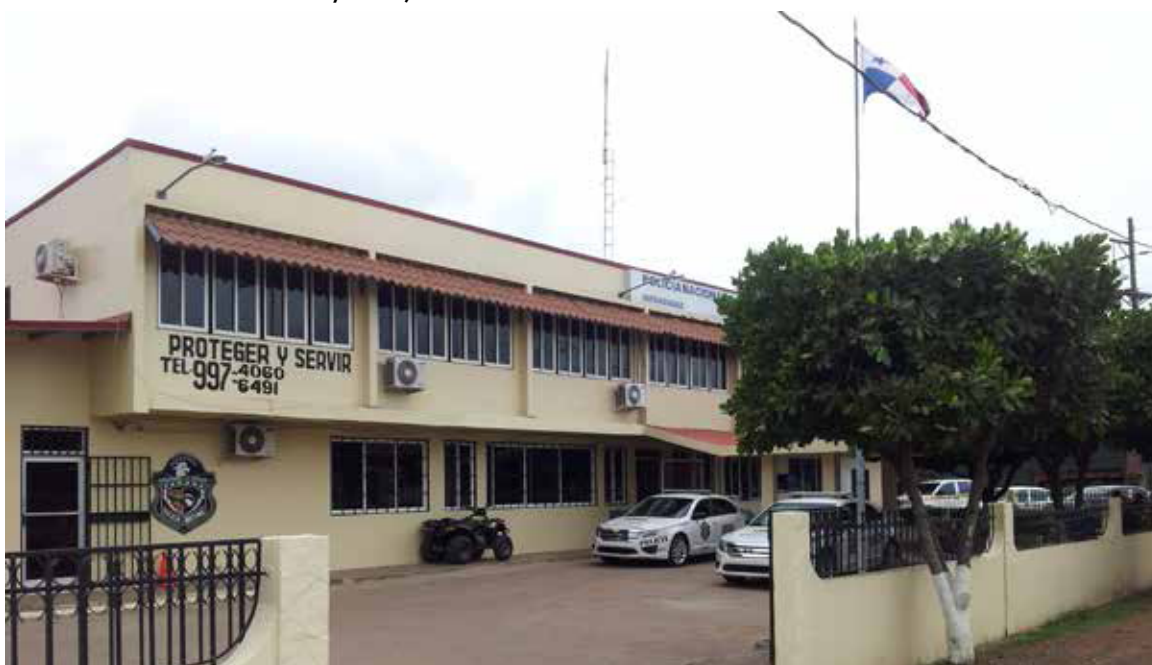
Desarrollo y suministro de planos, especificaciones técnicas, adición y remodelación del puesto policial de Aguadulce, incluye cuarto de comunicaciones. Monto B/. 217,550.81.
