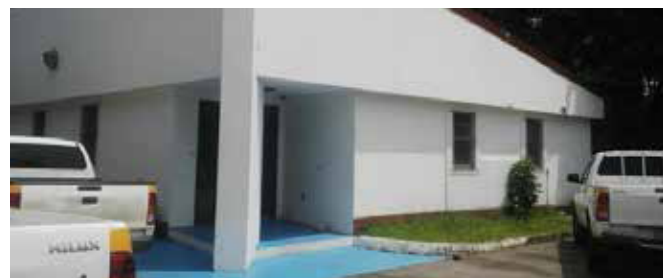
Edificio de la Dirección de Tecnología.
