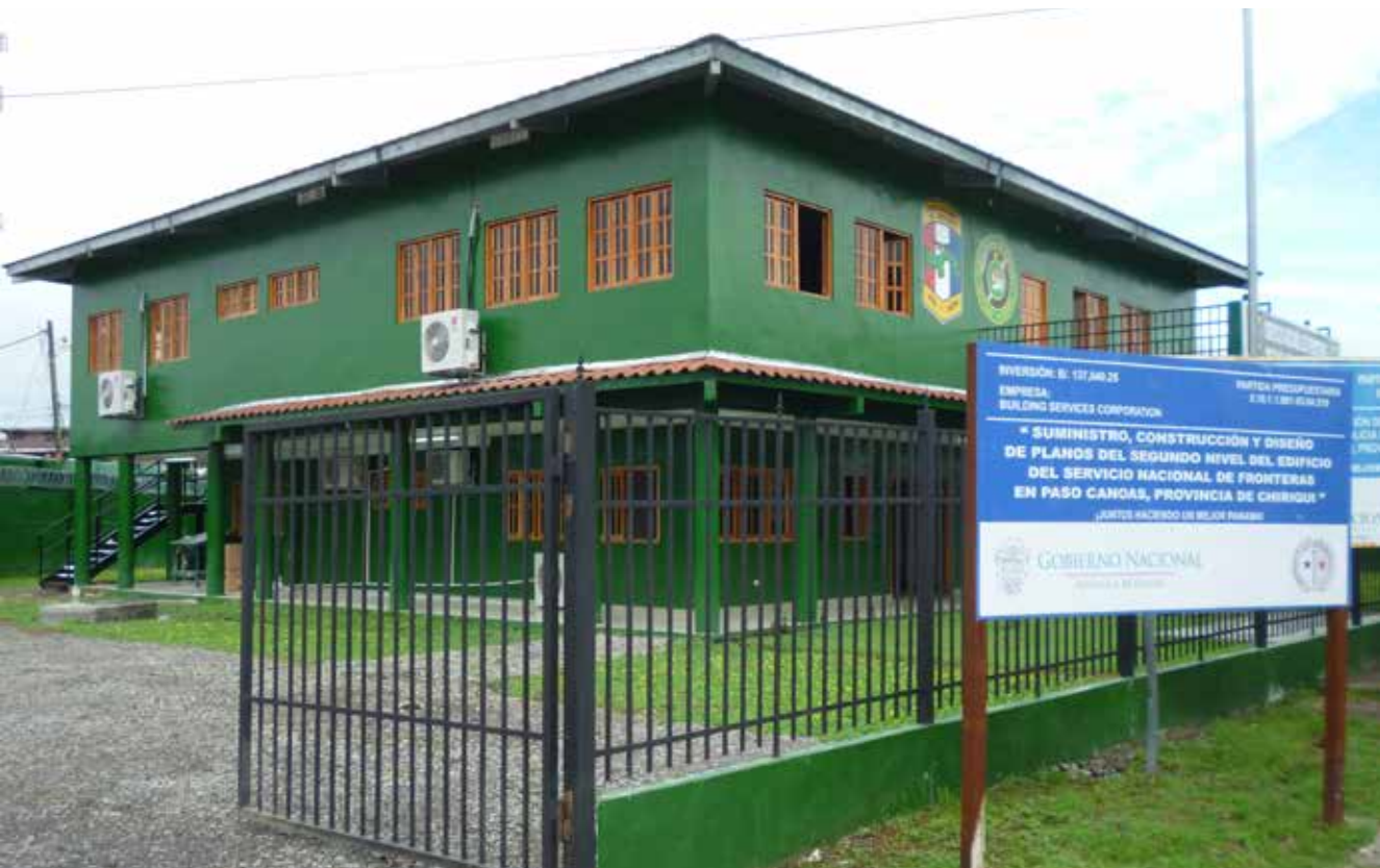
Suministro, construcción y diseño de planos del segundo nivel del edificio del Servicio Nacional de Fronteras en Paso Canoas, Chiriquí. (Segunda etapa). Monto B/. 137,040.25.
