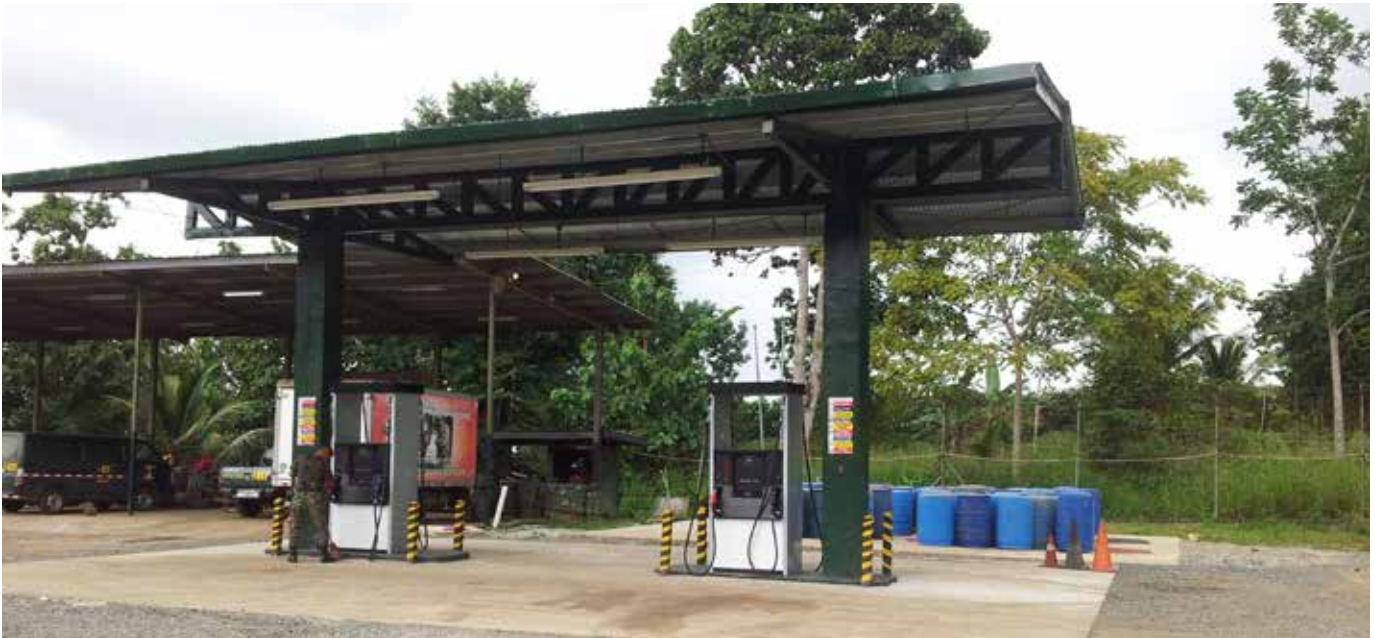
Construcción de estación de combustible en Metetí. Monto B/. 139,661.75.
