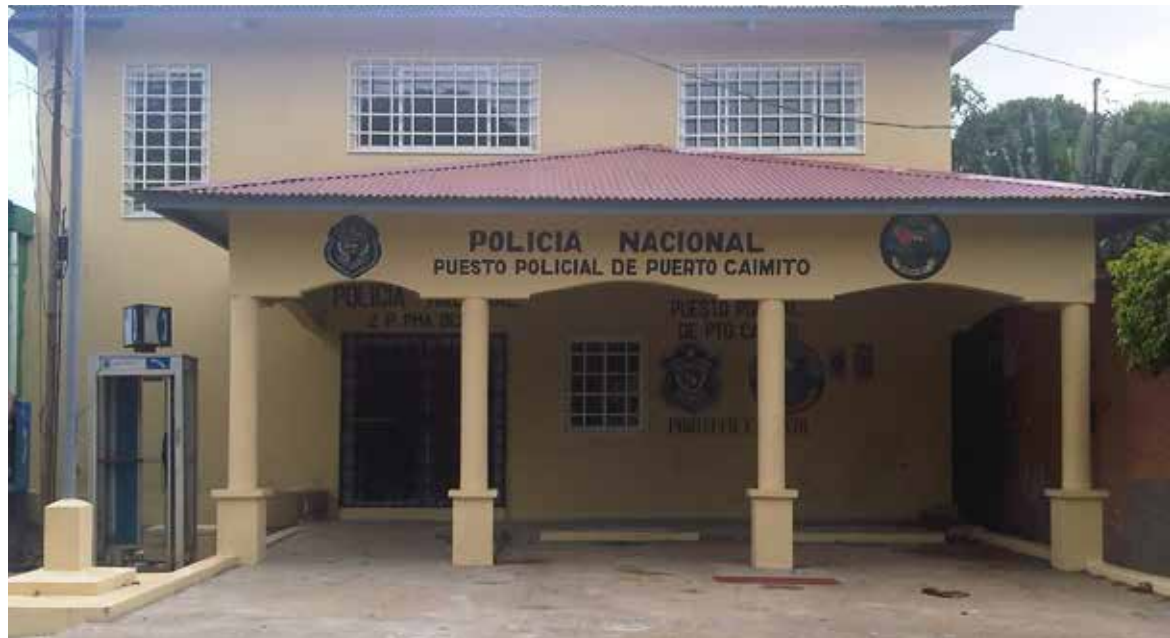
Diseño de plano, aprobación y construcción nueva y equipamiento del puesto policial de Puerto Caimito. Monto B/. 234,209.74.
