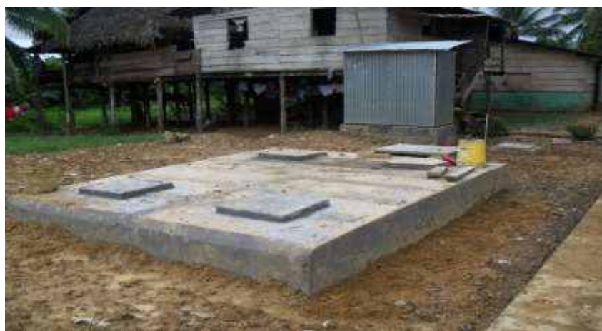
Construcción de fosas sépticas Bisira
