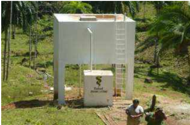
Figura N°3. Construcción de Acueductos Rurales
