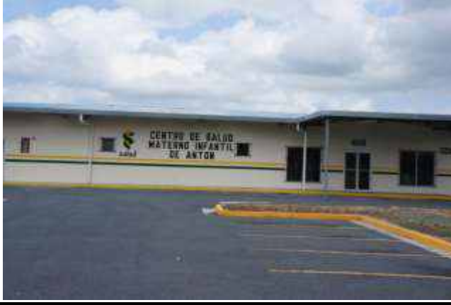
Construcción del Cuarto de Urgencia y Sala de Maternidad del Centro Materno-Infantil De Antón por B/.1,677,1712.50.
