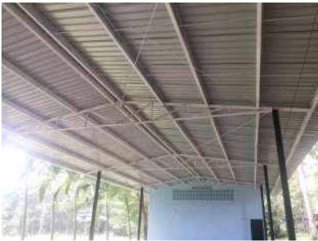
Compra e Instalación del techado de la capilla del INSAM
