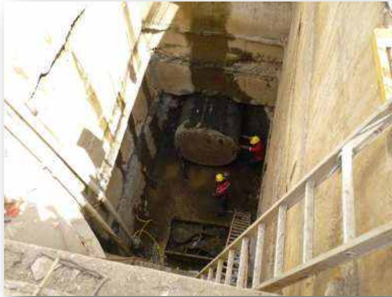
Salida de Microtunneladora (Sistema Interceptor Túnel)
