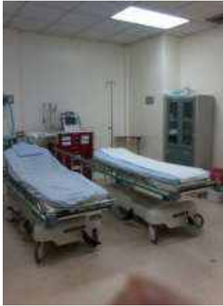
REMODELACIÓN DE URGENCIA PEDIATRICA
