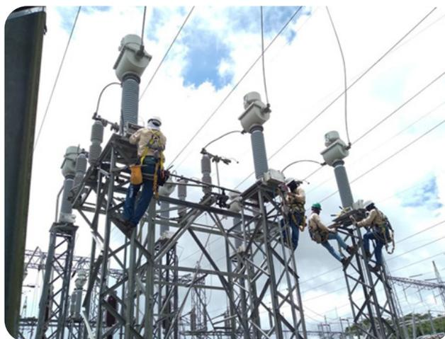
*Personal técnico realizando conexión de secundarios de nuevos CT's instalados para las protecciones de 115 kV del transformador T2 de S/E Progreso.*
