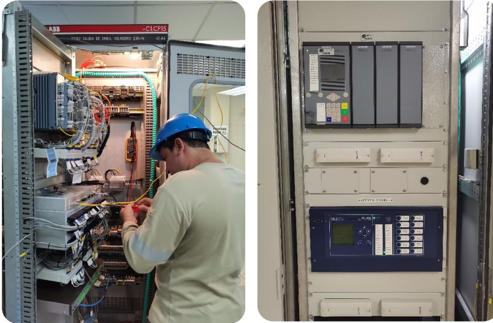
Trabajos de reemplazo de la protección secundaria de la LT 230-14A en SE Llano Sánchez. Izquierda: Realizando cableado de la nueva protección. Derecha: Nueva protección instalada (después)
