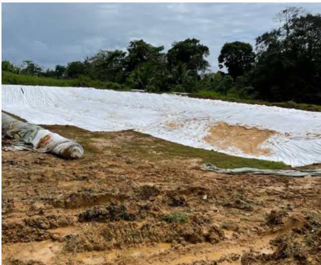
CONSTRUCCION DE TINA DE VERTIDO CON GEOMEMBRANA
