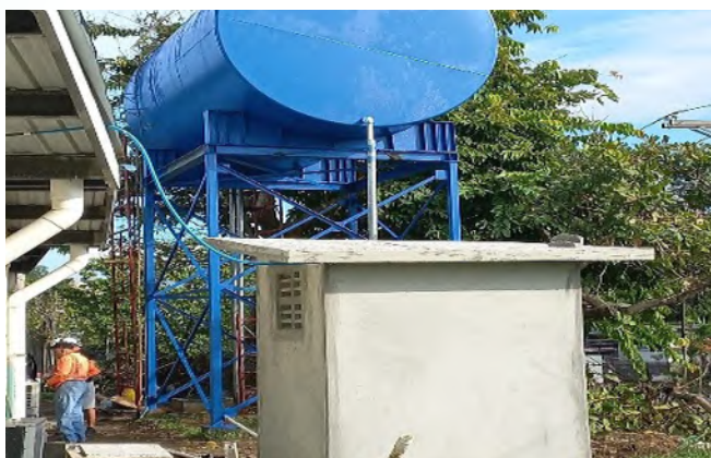
Reparación del tanque metálico existente de agua potable de 9,930 galones en IPHE Betanía.
