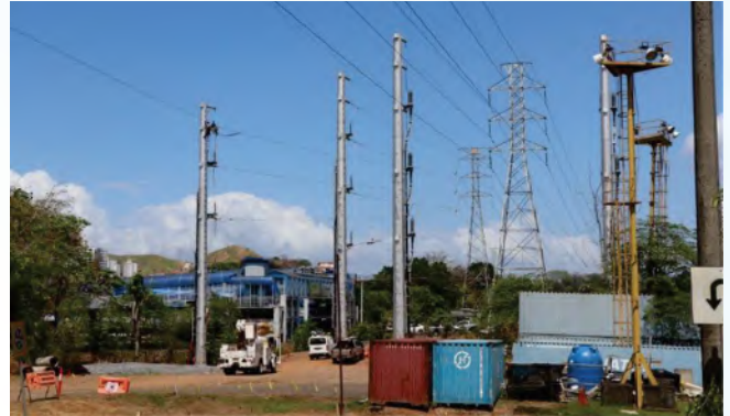
Reubicación de dos de las cuatro líneas eléctricas de alta tensión que pasan por los terrenos de la UTP.
