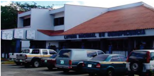
Foto.6. Fachada actual de la Dirección Provincial de Penonomé.
