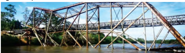
Antiguo puente ferroviario sobre el río Sixaola. (1908)
