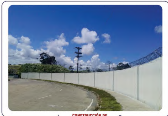
CONSTRUCCIÓN DE CERCA PERIMETRAL
