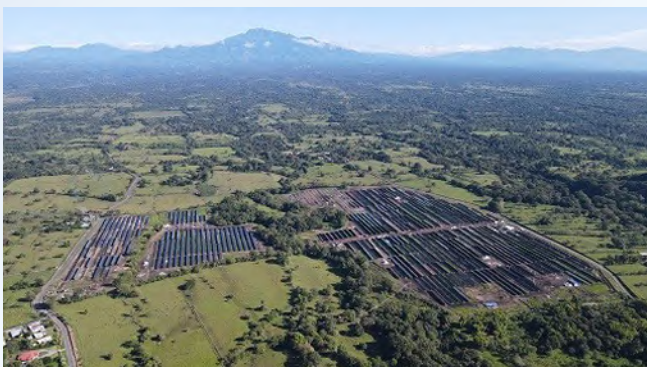
Plantas Solares en operación – Caoba, 9.97 MW y Cedro, 9.97 MW (Chiriquí).
