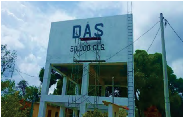
Fig. 3. Proyecto Construcción del acueducto de La Mata, Coclé. Inversión: B/. 119,401.30
