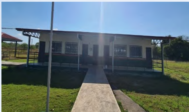
Construcción del nuevo techo de la pista de equinoterapia y acondicionamiento general del Módulo de Jaguito, Antón.
