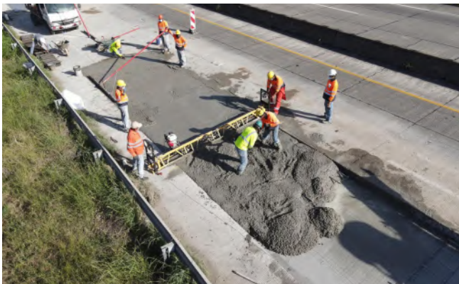
Mejoras en el pavimento de los corredores
