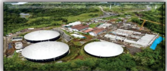
Figura No.1 Sabanitas, Módulo II
