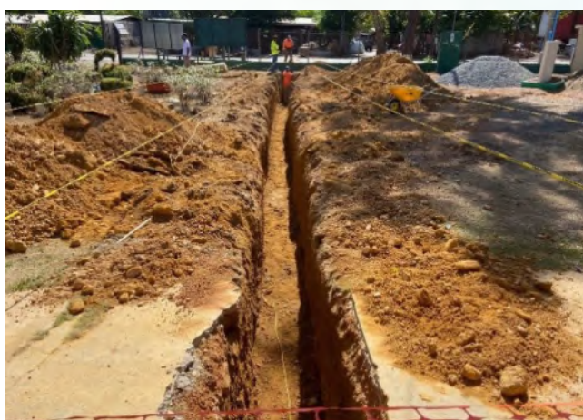
Adecuaciones del Sistema Sanitario y Conexión al Sistema de Alcantarillados en la extensión IPHE Aguadulce.
