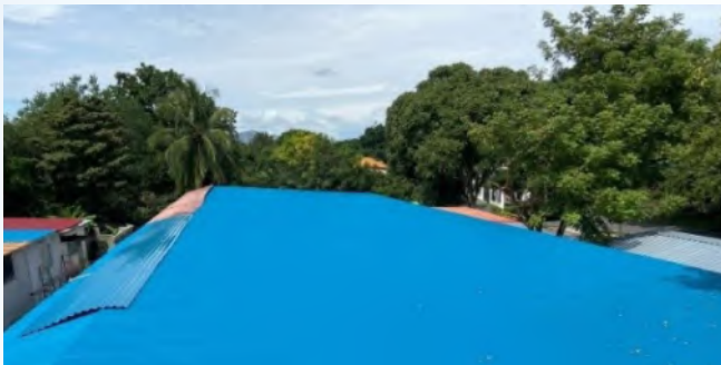
Acondicionamiento de la cubierta metálica en la extensión IPHE Penonomé
