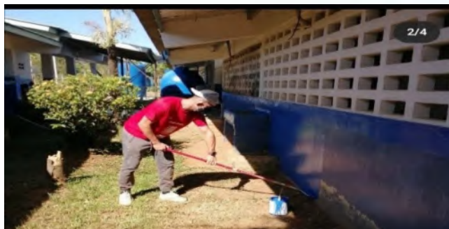
Mantenimiento de escuelas programa de CONESCUELAS 2022.
