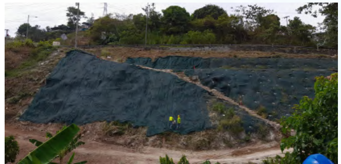
Adecuaciones de taludes críticos
