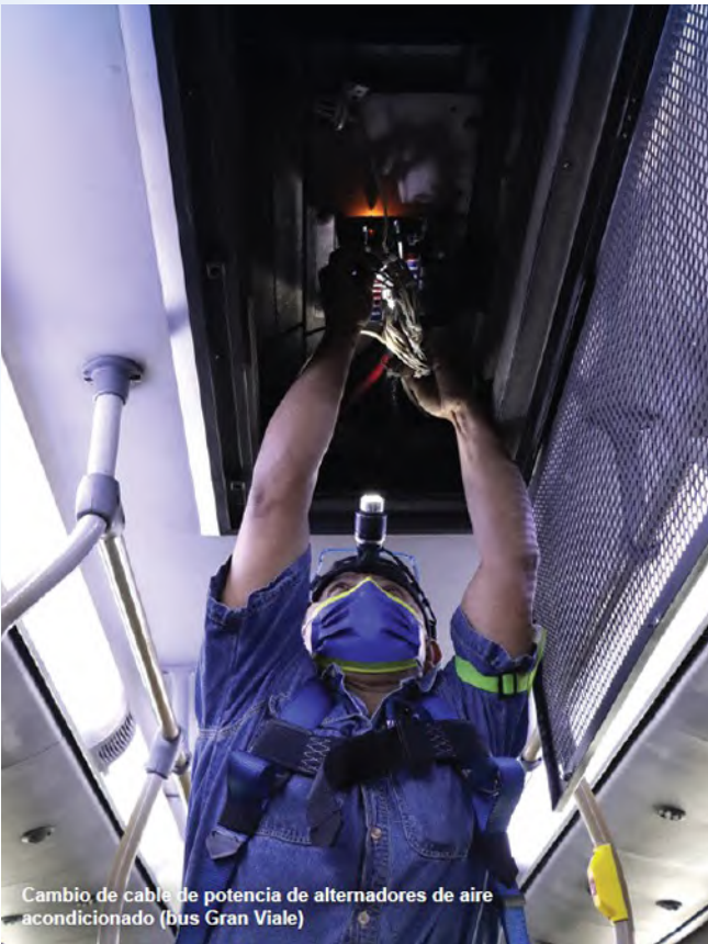
Reparación de aire acondicionado
