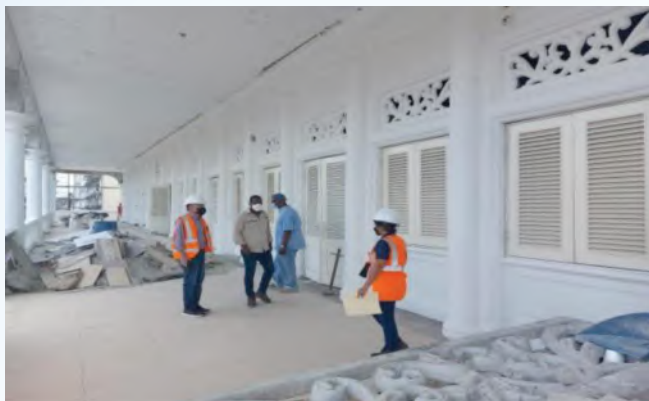
Foto.2. Parte exterior del segundo piso.
