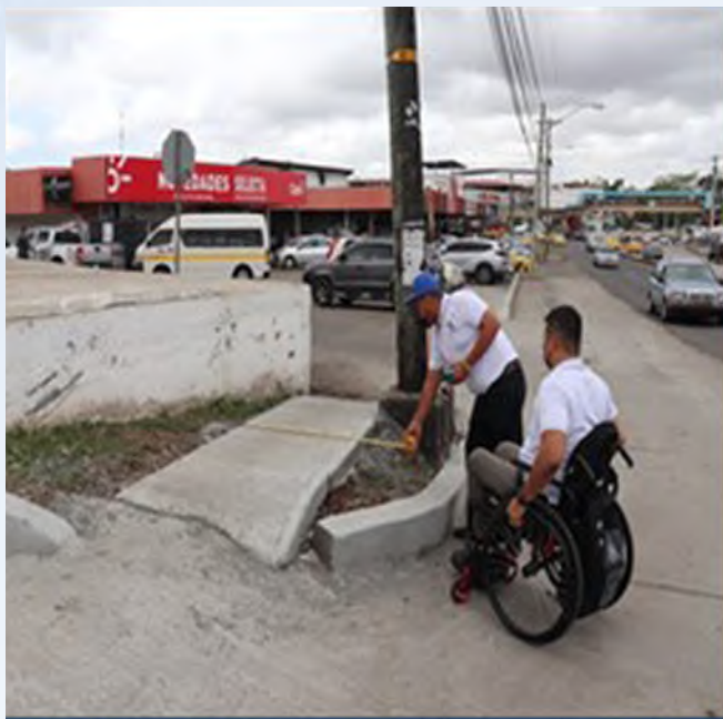
Arraiján en las aceras, parte urbana de la Línea 3 del Metro de Panamá.
