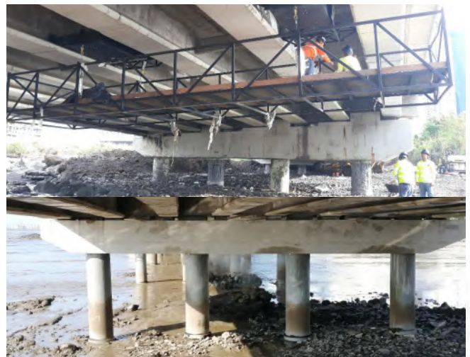
Rehabilitación de la subestructura del Tramo Marino (Corredor Sur)
