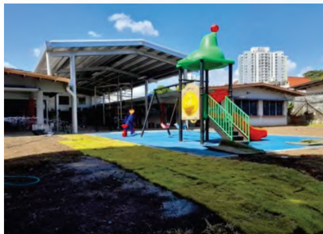
Foto.4. Vista general de las instalaciones C.O.I.F.
