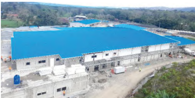
Nuevo Hospital de Almirante
