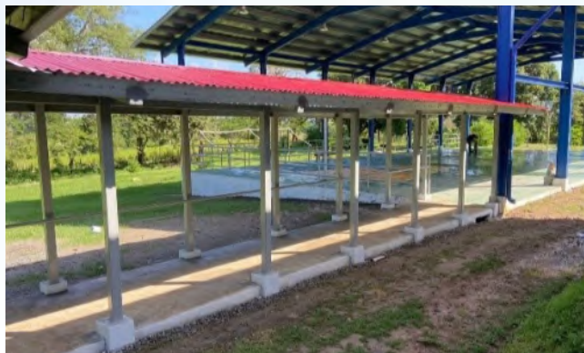
Suministro e Instalación de Barandales Perimetrales en Cancha en la extensión IPHE de Antón
