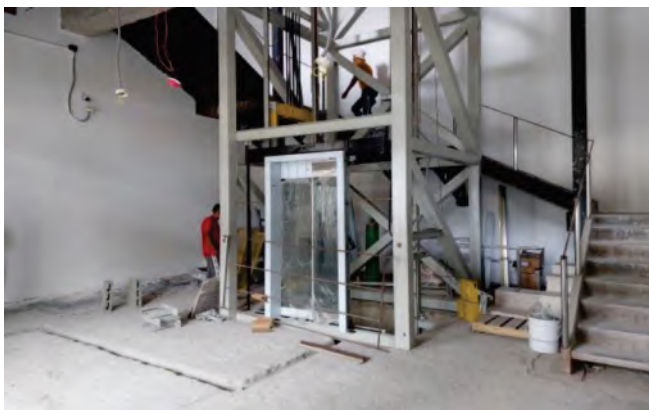
Foto.3. Instalación de elevadores.
