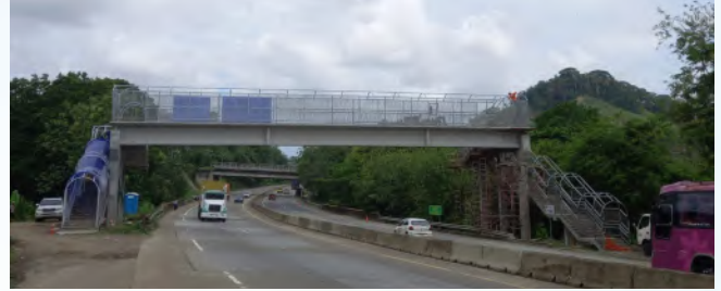
Construcción del puente peatonal Guna Nega (Corredor Norte)
