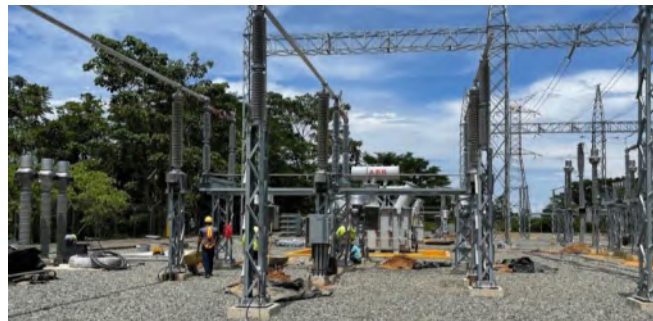
Figura 3. Montaje de reactores en subestación Changuinola.
