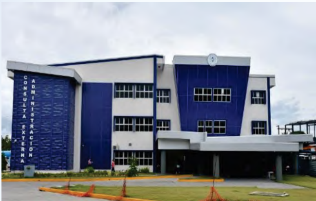
Consulta Externa del Nuevo Hospital Dionisio Arrocha
