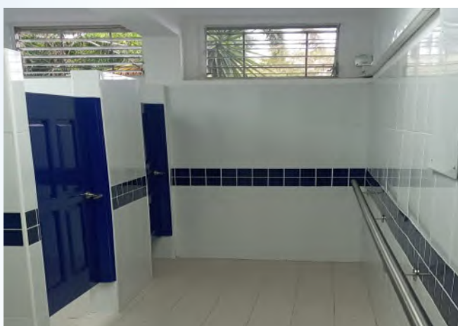
Adecuación de los servicios sanitarios de la Escuela Nacional de Sordos y Escuela Nacional de Ciegos Helen Keller
