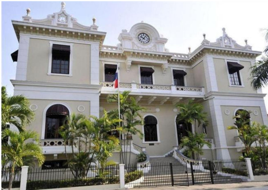
Está en proceso la restauración de Edificio Sede declarado monumento histórico
