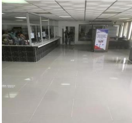
Instalación de porcelanato en las áreas de caja, lobby y entrada de Dirección provincial de Chiriquí - David
