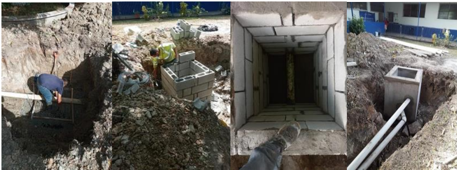
Construcción de cámara séptica y trampa de grasa en el Centro Estudiantil Victoriano Lorenzo Coclé
