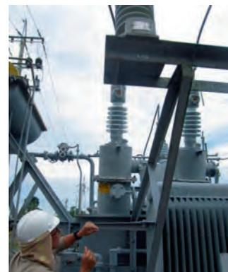
*Etiquetado color amarillo de equipos eléctricos sospechoso de contener PCB's en equipos eléctricos en desuso. Proceso de Gestion de Residuos e Inventario de Desechos peligrosos de ETESA.*
