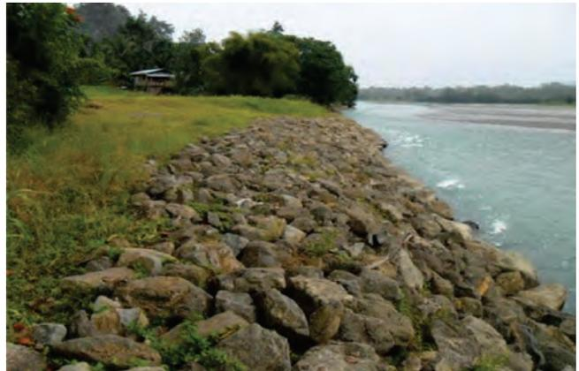
Construcción del muro enrocado, para la protección de la toma.
