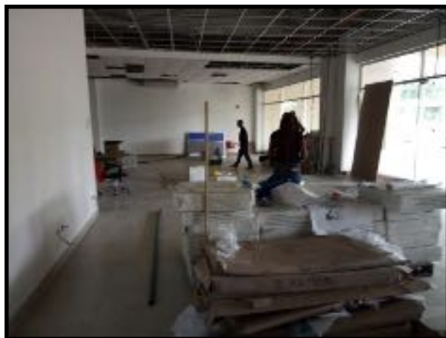
Foto: Elevación de la sede inicialmente.
