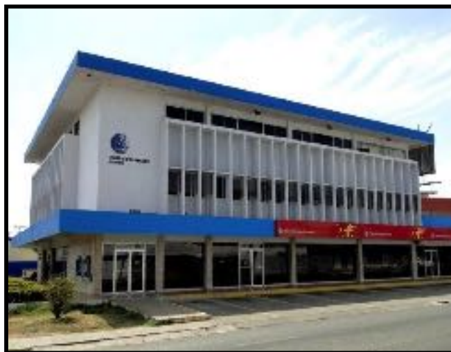
Foto: Elevación de la sede inicialmente.
