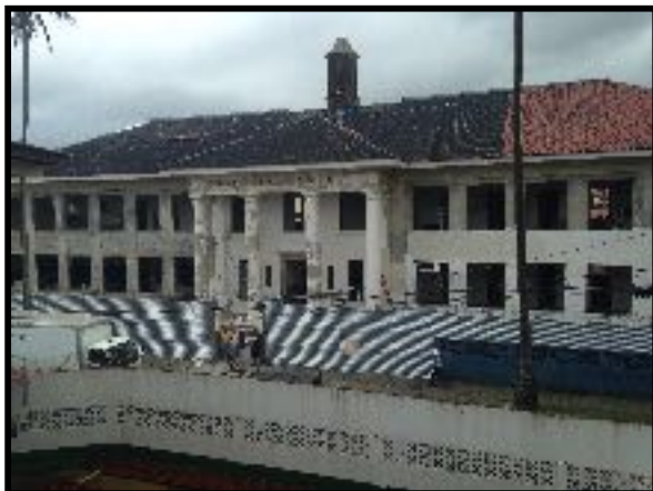
Foto: Elevación de la sede inicialmente.
