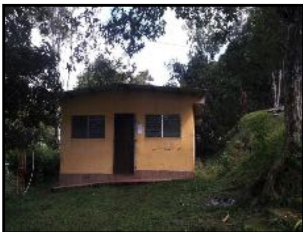
Foto: Elevación de la sede inicialmente.
