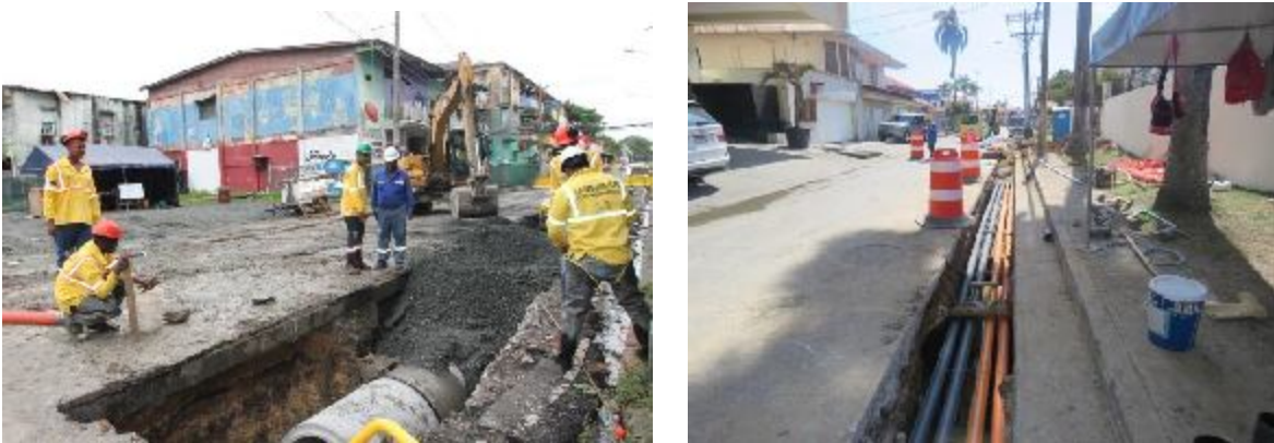
Mejoramiento del sistema de acueducto y soterrado de cables eléctricos.
