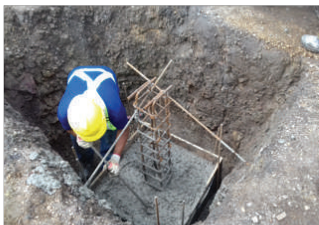
Excavación de fundaciones y Compactación del Concreto – Escuelas Cerro Algodón Proyecto Distrito de Müna 23/6/2016
