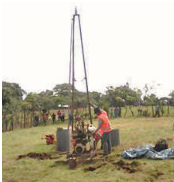
Estudios de Suelo y Percolación en la Escuelas Tijeras y Las Trancas, Proyecto Distrito de Müna. 2/6/2016
