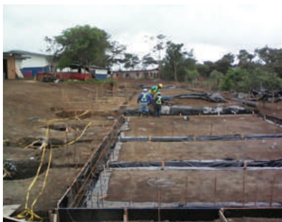
Excavación de fundaciones y Compactación del Concreto – Escuelas Cerro Algodón Proyecto Distrito de Müna 23/6/2016
