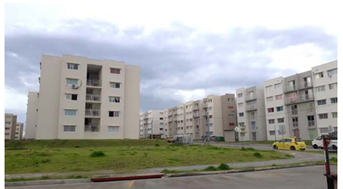
La obra contempla edificios de planta baja y cuatro altos.
