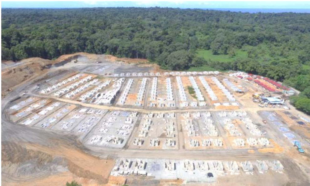
Urbanización Isla Colón, con 410 soluciones de vivienda.
